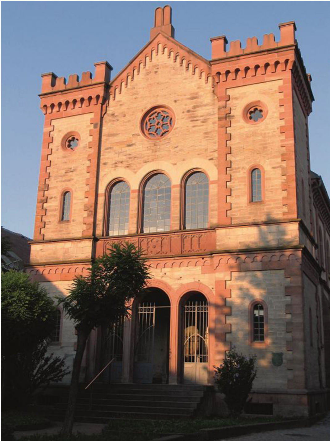
Die ehemalige Synagoge Kippenheim (c) Förderverein Ehemalige Synagoge Kippenheim e. V.
